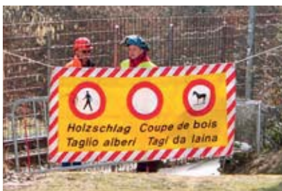
1 Absperrung eines Fusswegs mit einer Absperrplane
