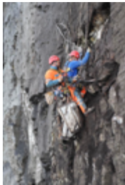
1 Felsicherungsarbeiten stellen höchste Anforderungen an die Arbeitsvorbereitung und Ausbildung der Mitarbeitenden.
