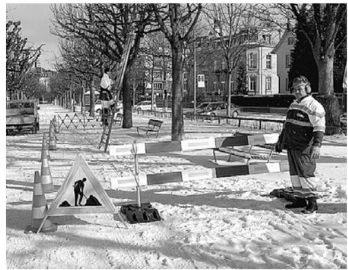
1 Der Gefahrenbereich ist signalisiert und für Drittpersonen abgesperrt.
