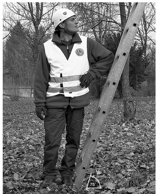
2 Die richtige Neigung lässt sich mit der Ellbogenprobe bestimmen. Bei einem Anstellwinkel von etwa 75° stehen Leitern am sichersten und können am bequemsten bestiegen werden.
