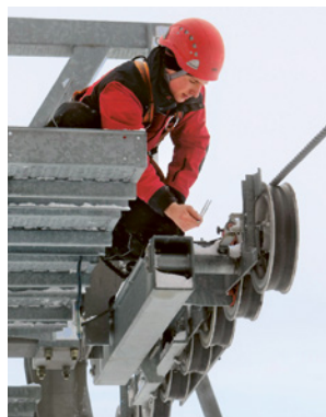
2 Auf den Stützen kann der Bruchstab entfernt werden.
