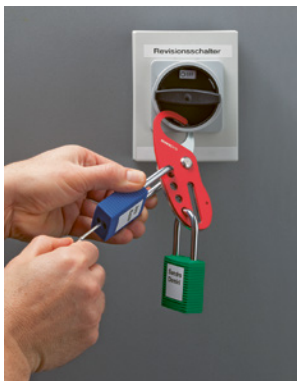
1 Mehrfachschliessbügel mit persönlichem Vorhängeschloss sichern
