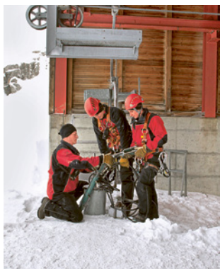
Regel 1 Arbeiten sorgfältig planen.
